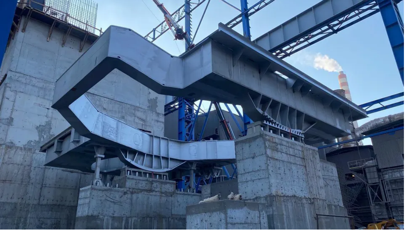
01 / Devirme platformu imalatı
